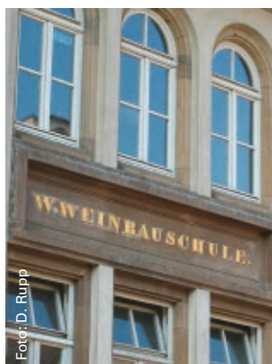
Bild 1a Das Schulhaus von 1898 - Württembergische Weinbauschule-.
